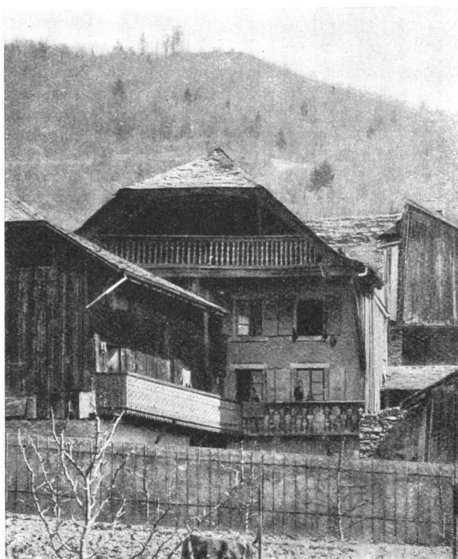
Fig. 13. Maisons à Tercier, avec une jolie galerie ancienne à balustres, et deux autres disparates et sans grâce. — Abb. 13. Häuser in Tercier. Neben einer schönen Laube gewahrt man zwei nichtssagende und hässliche.
