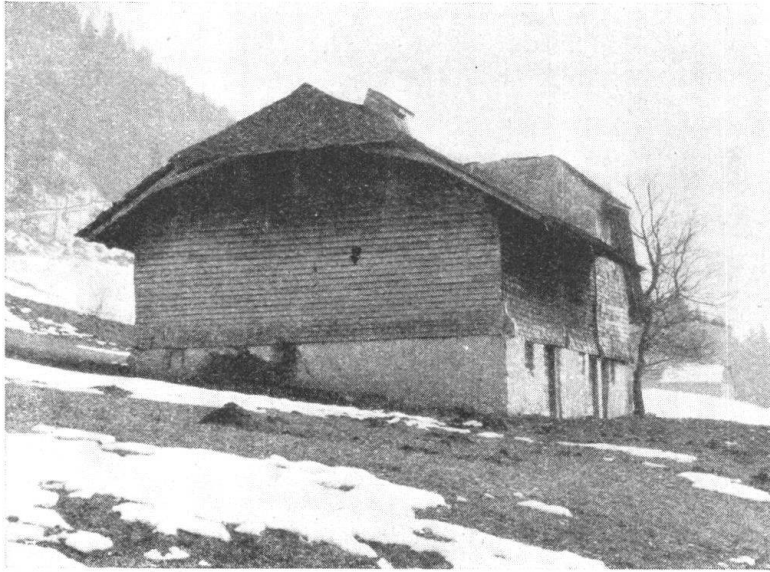
Fig. 5. Chalet vaudois, aux Pléiades sur Vevey; „tavillonné“ à la mode fribourgeoise. — Abb. 5. Waadtländer Sennhütte mit Schindelschirm. Aux Pléiades über Vivis.
