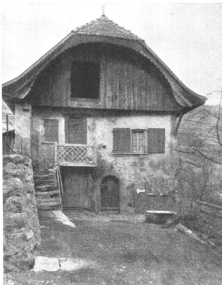
Fig. 4. Maison à Rivaz, avec toit bernois sur socle savoyard. Abb. 4. Haus zu Rivaz, mit Berner Dach auf savoyischem Unterbau.
