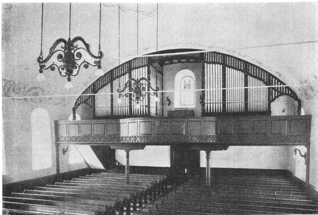
Abb 16. Innenraum der Kirche in Betschwanden, nach glücklichem Umbau durch die Architekten B. S. A. Streiff und Schindler, Zürich. Alter dekorativer Fries an der Empore beibehalten; die eisernen Querstangen mussten aus statischen Gründen bleiben. — Fig 16. Intérieur de l'église de Betschwanden, après l'excellente rénovation exécutée par les architectes Streiff et Schindler, Zurich. L'ancienne frise décorant la galerie a été conservée; les barres de fer transversales n'ont pu être enlevées, elles étaient indispensables à la solidité du bâtiment.
