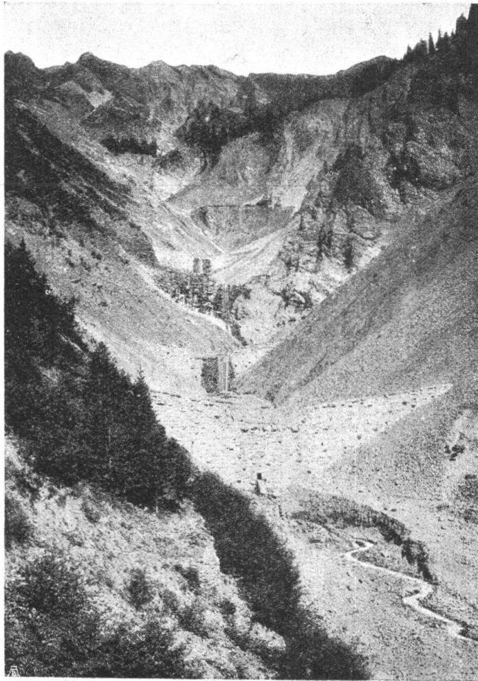
Abb. 2. Lammbach bei Brienz. Verbaut. Gesamtansicht. Fig. 2. Correction du Lammbach, près Brienz. Vue générale.
