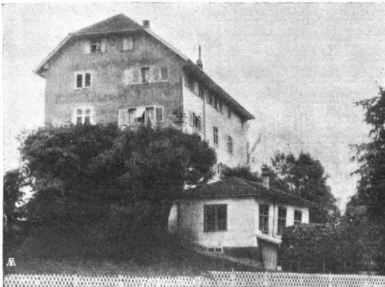
Abb. 5. Schloss Wetzikon in heutiger Gestalt. Das unschöne kleine Gebäude vor dem Haupthause sollte durch Überwachsen mit Grün dem Blick etwas entzogen werden. Das gleiche gilt von der wenig glücklichen Einfriedigung im Vordergrund. — Fig. 5. Château de Wetzikon dans son état actuel. Le petit bâtiment sans caractère qui s'élève devant le château ne pourrait-il être caché aux regards par un peu de verdure? et ne pourrait-on pas en faire autant de la clôture disgracieuse du premier plan?
