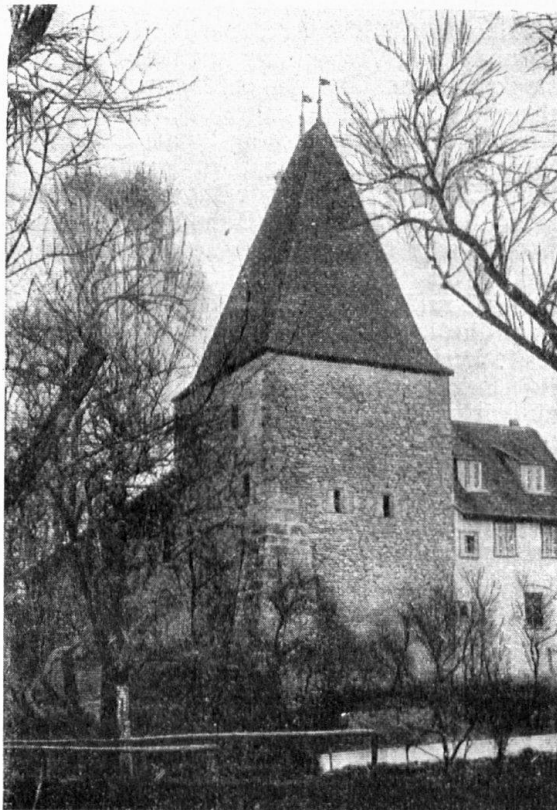
Abb. 13. Alter Turm in Wiedlisbach. Das im ganzen wohlhaltene, in Einzelheiten unlängst glücklich renovierte Wahrzeichen des Ortes. — Fig. 13. Vieille tour à Wiedlisbach, restaurée avec goût il y a quelque temps, et qui donne à la petite ville son cachet particulier.
