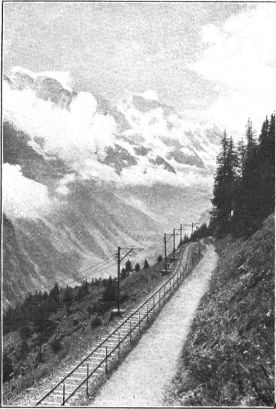
Abb. 5. Vom Schönheitsstandpunkt aus wäre die umgekehrte Anordnung: zuinnerst Träger, dann das Geleise und zu äusserst der Fussweg, besser gewesen. Die Träger sind eckig und unschön. — Fig. 5. Au point de vue esthétique l'ordre inverse aurait été préférable: à l'intérieur les poteaux, ensuite les rails et extérieurement le sentier. Les poteaux sont anguleux et sans grâce.
