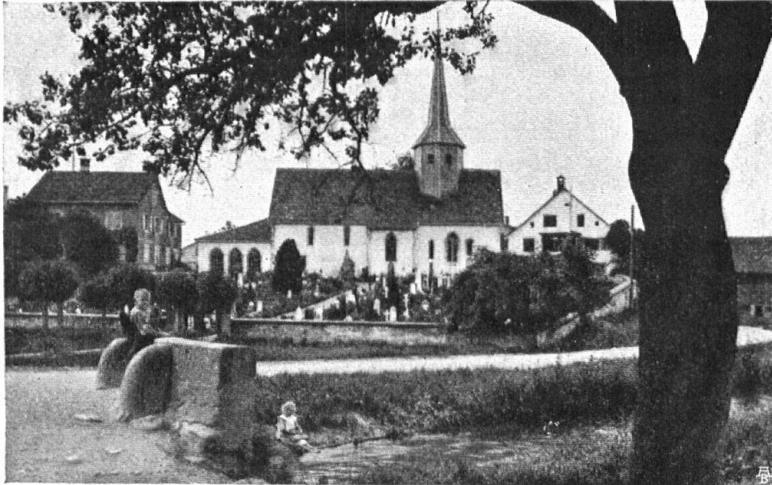
Abb. 9. Die alte Kirche St. Johann in Kurzdorf. Fig. 9. L'ancienne église St-Jean, à Kurzdorf.
