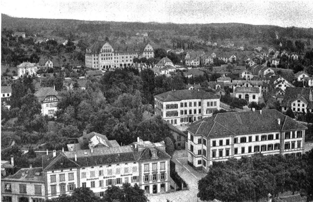
Abb. 4. Neue und alte Kantonsschule. Im Vordergrund rechts der nüchterne ältere Bau; im Hintergrunde die künstlerisch gegliederte, durch kräftige Dachbildung ausgezeichnete neue Kantonsschule. Druckstock der Kunstanstalt Brunner & Cie., Zürich. — Fig. 4. La nouvelle et l'ancienne école cantonale. Au premier plan, à droite, l'ancien bâtiment de style simple et modeste; à l'arrière-plan la nouvelle école cantonale, construction aux proportions bien équilibrées, à la toiture imposante et caractéristique.
