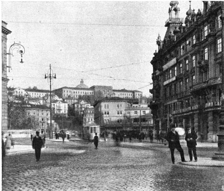
Abb. 21. Blick auf das Polytechnikum in Zürich. Hinter dessen Hauptfassade guckt jetzt ein Stück der neuen Kuppel des Erweiterungsbaues hervor. — Fig. 21. L'Ecole polytechnique fédérale, à Zurich. Derrière la façade principale on voit une partie de la coupole qui couronne la nouvelle annexe.
