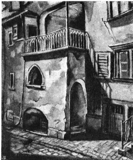
Abb. 8. Hinterhaus zur „Glocke“. (Ölbild von Albert Edelmann.) Der mittelalterlich anmutende Treppen-Vorbau führt zu einer zwei Stockwerke hohen, offenen Halle, die als Lagerplatz der für den Marktverkehr bestimmten Waren diente.
