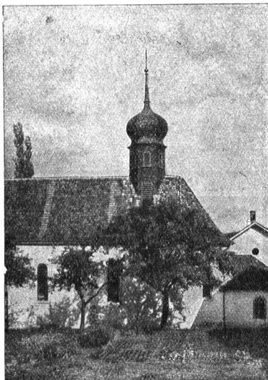
Dachreiter in Eternit, geschlaufte Deckung, kupfer- braun
