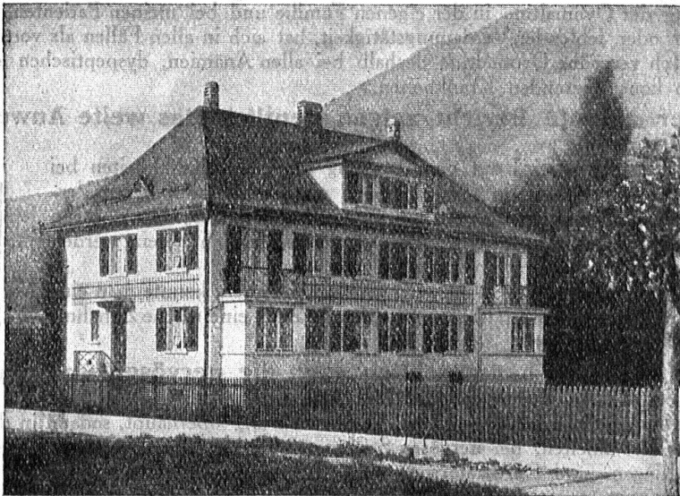
Wohnhaus in Ziegelbrücke Bedachung: Eternit-Doppeldeckung, kupferbraun
