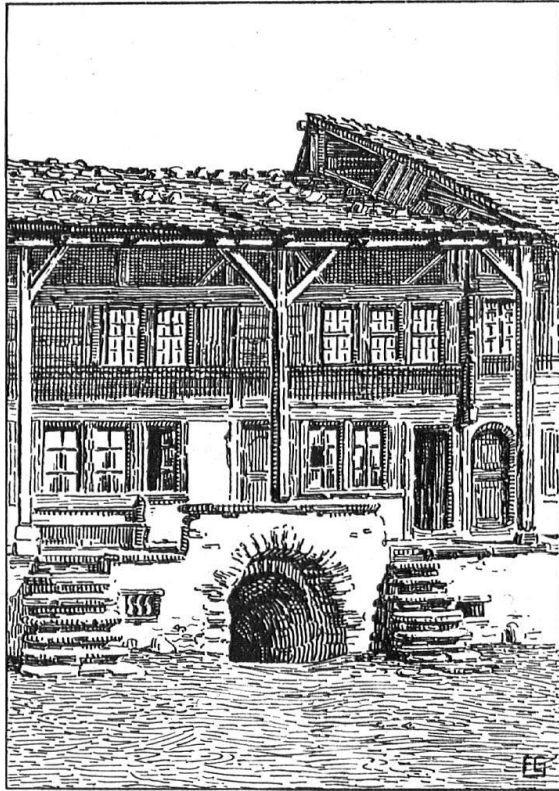
Abb. 5. Laubenhaus an der Untern Gasse mit „Torisgang“.
