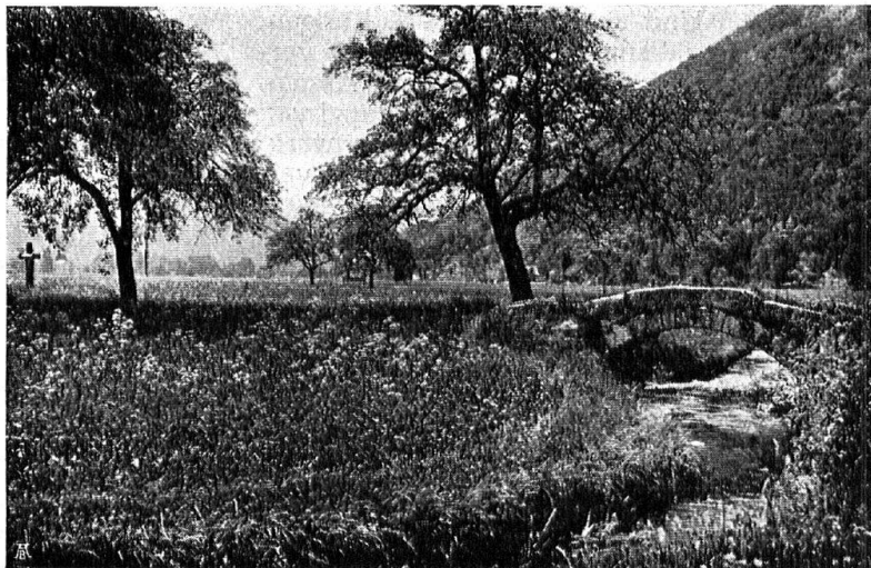
Abb. 21. Brückenbogen aus Granit-Findlingen am Mühlebach in Stans. 1922 unnötigerweise durch Sprengung beseitigt. — Fig. 21. Pont à arche en granit de blocs ératiques, à Stans, qui a été démoli sans utilité aucune en 1922.
