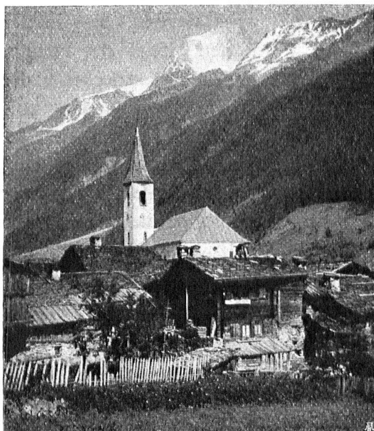
Abb. 21. Kippel im Lötschental. Das Blechdach der Kirche passt schlecht zum Dorfbild. Aufnahme von H. Gattiker in Gümligen. — Fig. 21. Kippel, dans le Lötschenthal. La toiture de fer-blanc du clocher détonne désagréablement au milieu de ce village alpestre. Cliché H. Gattiker à Gümligen.
