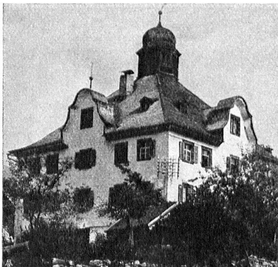
Abb. 8. Haus der Familie de Mont zu Villa im Lugnez; Schindelnageldach. Aufnahme von K. Ramseyer. — Fig. 8. Maison de la famille de Mont, à Villa, en Lugnez; toit de tavillons. Cliché K. Ramseyer.
