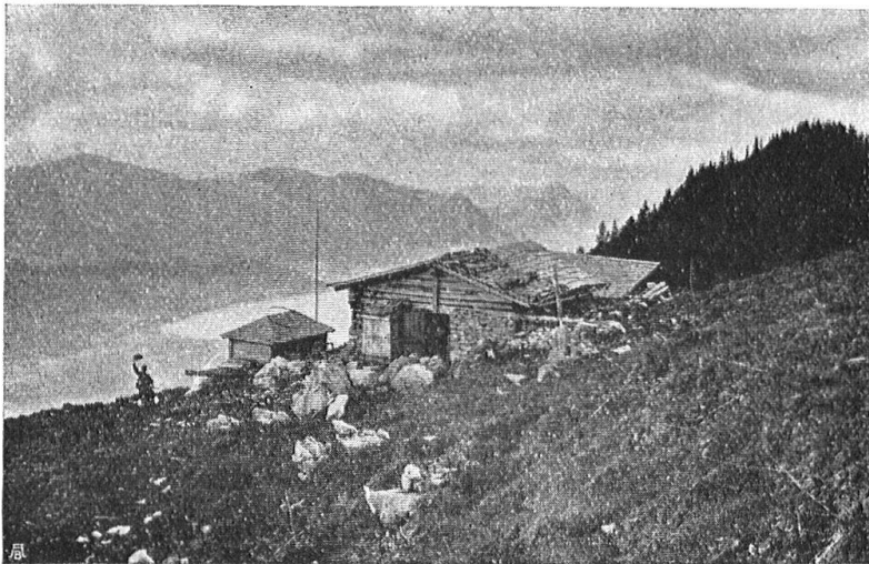
Abb. 3. Alphütte auf Stanserhorn. Schindelschwerdach und Schindelnageldach. — Fig. 3. Chalet sur une alpe du Stanserhorn. Toit de bardeaux, en partie cloués, en partie consolidés par des pierres.
