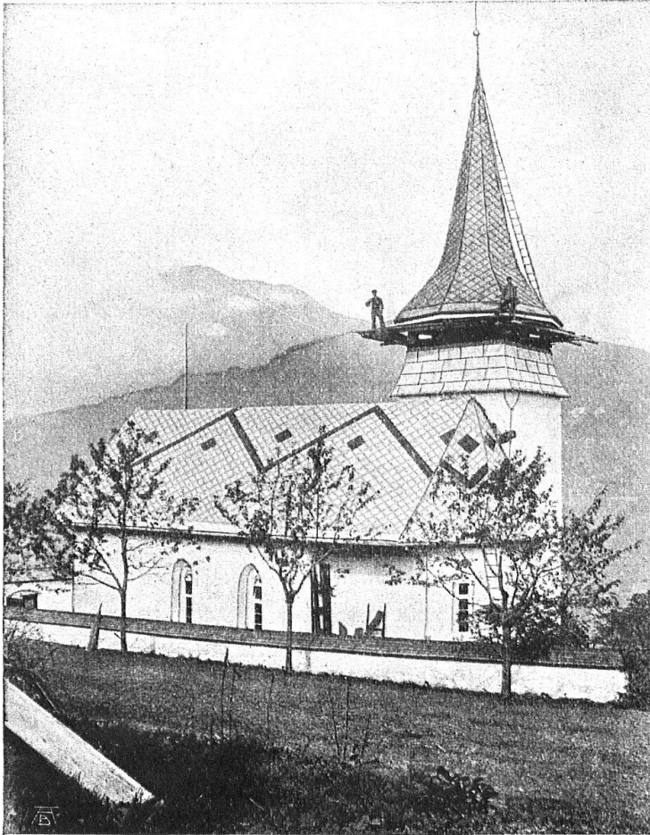
Abb. 23. Das Kirchlein von Conters im Prättigau. Das frühere Schindeldach wurde durch rot und schwarz gestrichene Blechplatten ersetzt! (Heimatschutz 1907, pag. 7.) — Fig. 23. Le clocher de Conters dans le Prättigau. L'ancien toit de bardeaux a été remplacé par des plaques de tôle à raies rouges et noires! (Heimatschutz 1907, page 7.)
