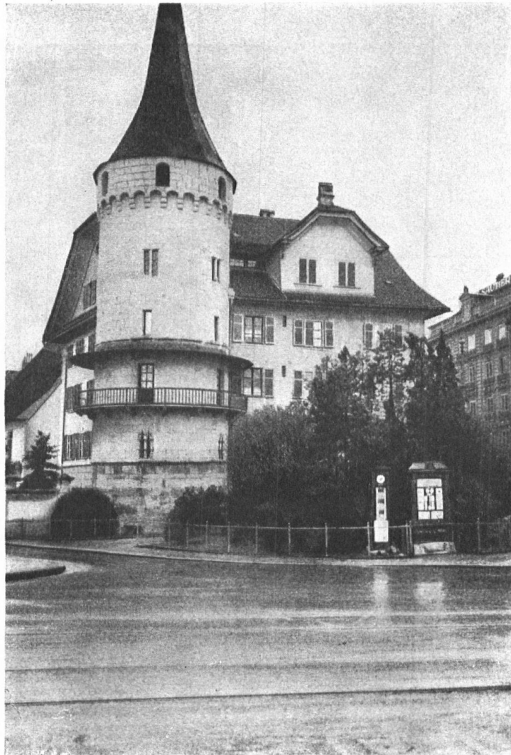
Abb. 7. zur Gilgen-Haus; davor eine städtische Anlage aus ein paar särbelnden Pflanzen ohne Zusammenhang und architektonische Wirkung (zu vergleichen die Bepflanzung, Abb. 10); deplazierte Reklamen. Da wäre eventuell der Platz für einen Monumentalbrunnen! — Fig. 7. Maison zur Gilgen. Devant un jardin public doit les arbres raides et sans grâce sont plantés sans le moindre souci esthétique ni aucun effort pour les mettre en accord avec l'architecture environnante. (Comparer l'article: les plantations d'arbres, fig. 10.). En outre un édicule de réclame fort déplaéc. Il y aurait ici un emplacement très favorable pour une fontaine monumentale.
