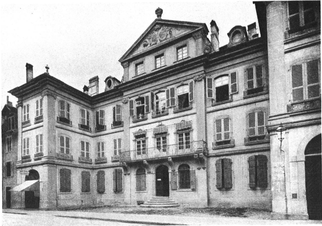
Fig. 6. Neuchâtel: Maison Erhard Borel. Construite en 1770. Joli fronton à emblèmes, type d'architecture française adaptée aux besoins du pays. — Abb. 6. Haus Erhard Borel, errichtet 1770. Hübscher plastisch geschmückter Giebel. Ein Stück französische Architektur, den örtlichen Bedingungen angepasst.
