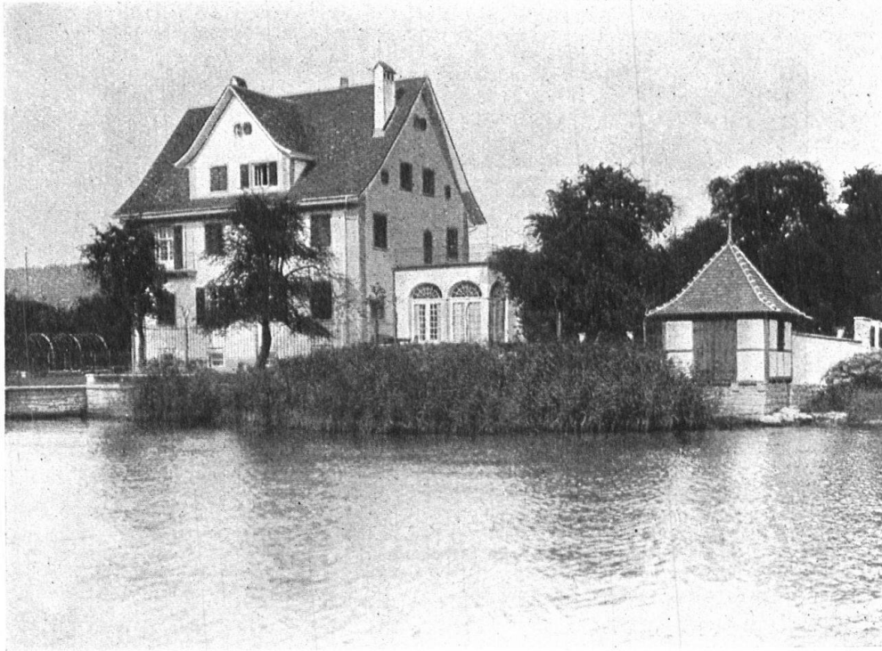
Abb. 7. Hübsches Häuschen als Eckmotiv, in ländlichen Bauformen am Zürichsee. Fig. 7. Joli pavillon de formes rustiques. Solution heureuse pour l'angle d'un jardin. Rives du lac de Zurich.
