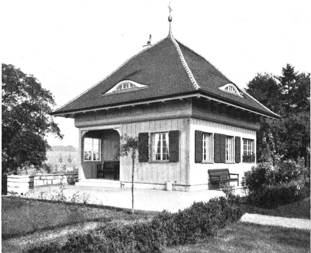
Abb. 10. Sommerhaus im Garten, Winterthur. Fig. 10. Pavillon avec chambres d'habitation, dans un jardin à Winterthur.
