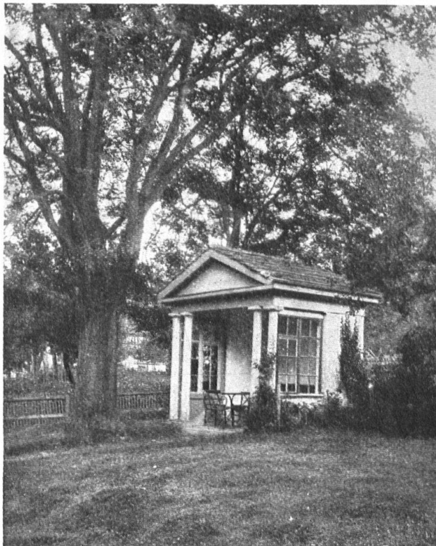
Abb. 5. Häuschen im Schlossgarten zu Kefikon. (18. Jahrhundert). Aufnahme von Hausamann, Heiden. — Fig. 5. Pavillon dans le jardin du château de Kefikon. (XVIII e siècle). Cliché Hausamann, à Heiden.
