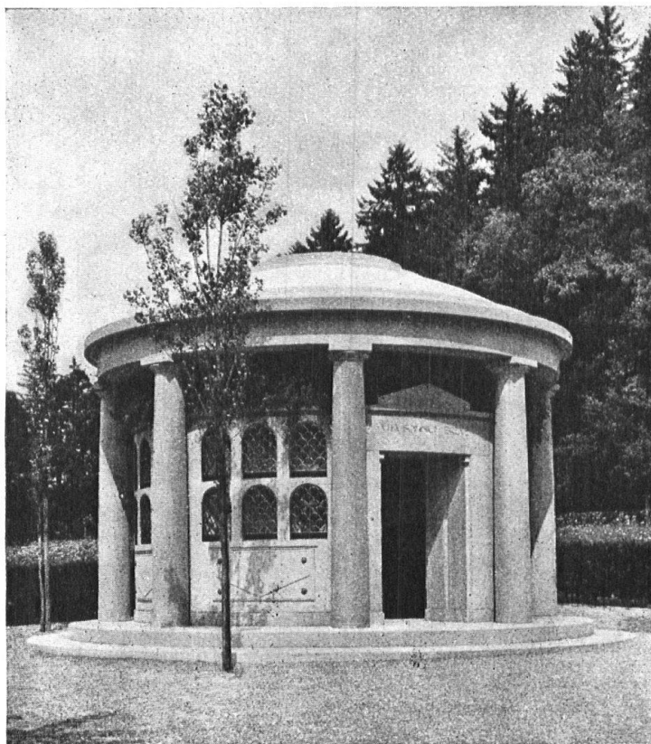
Abb. 18. Das Kolumbarium in Winterthur. Architekten Rittmeyer & Furrer, Winterthur. — Fig. 18. Le colombaire de Winterthour, Rittmeyer & Furrer, architectes, Winterthour.
