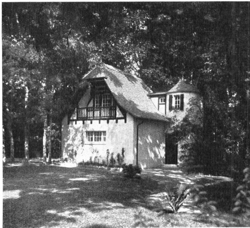
Abb. 10. Garage in einem Garten zu Basel. Reizvolle architektonische Motive, Betonung des Doppelzweckes (Garage und Wohnung). Besitzer H. Koechlin-Ryhiner, Architekt H. E. Ryhiner, Basel. — Fig. 10. Garage dans un jardin, à Bâle. Charmants motifs d'architecture. La double destination du bâtiment: garage et maison d'habitation a été marquée avec bonheur. H. Koechlin-Ryhiner, propriétaire; H. E. Ryhiner, architecte, Bâle.
