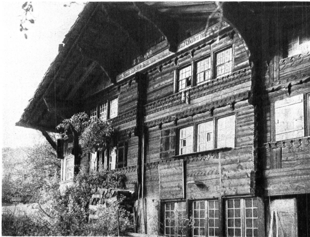
Abb. 5. Chalet im Bergdorf Habkern. Auch hier wird der plastische Schmuck durch Farbe ergänzt (schwarzer Spruch auf weissem Band und Jahrzahl). Zu beachten bei den Fenstern des Erdgeschosses die nach oben aufklappbaren Fensterladen. — Fig. 5. Chalet à Habkern. Ici également l'ornementation plastique est complétée par une décoration en couleurs (légende et date en caractères noirs sur bande blanche). Remarquer au rez-de-chaussée les contrevents relevés au-dessus des fenêtres.
