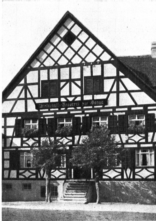
Abb. 1. Wirtschaft und Brauerei z. Sonne, Steckborn. Der Riegel wurde anlässlich einer Renovation freigelegt und heute präsentiert sich das Haus mit seiner günstigen Lage am Eingang zum Städtchen ganz vorteilhaft. — Fig. 1. Restaurant et brasserie du Soleil à Steckborn. A l'occasion de la rénovation de ce bâtiment les pans de bois du colombage ont été remis à jour. Aujourd'hui cette belle maison, à l'entrée de la petite ville, produit un excellent effet.
