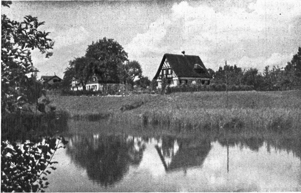
Abb. 12. Das „Weyerhüsli“ Amriswil, 1923 erbautes Einfamilienhaus in gut thurgauischen Formen und Farben. Fig. 12. Le «Weyerhüsli» à Amriswil, maison familiale, d'une bonne architecture, construite en 1923.
