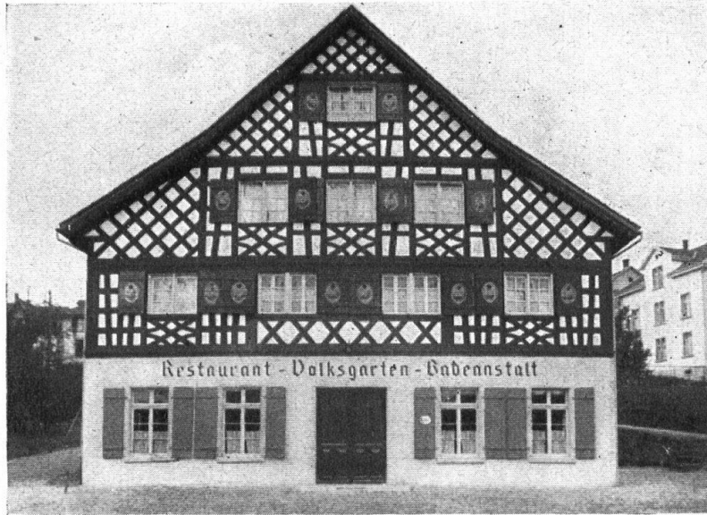
Abb. 11. Der Volksgarten Romanshorn, früher ein hässliches, rotes Putzhaus, nach seiner glücklichen Renovation. Aufnahme von Photogr. Schwarz in Romanshorn. — Fig. 11. Le restaurant «Volksgarten» à Romanshorn. Un affreux crépis rougeâtre ayant été éloigné, cette maison a retrouvé sa belle apparence. Cliché de M. Schwarz, photographie à Romanshorn.
