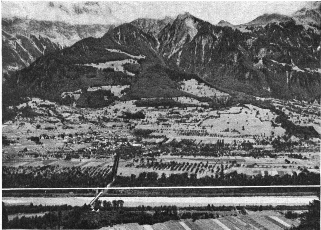
Abb. 1. Die weiße Linie bezeichnet die Achse der Leitungsstrasse; letztere wird gegen Maienfeld sowie gegen den Rhein hin durch höheren Baumwuchs verkleidet und dadurch der Sicht entzogen. — Fig. 1. La ligne blanche indique l'axe de la conduite électrique; celle-ci sera masquée du côté de Maienfeld, comme du côté du Rhin, par un rideau de hauts arbres qui la rendront invisible.
