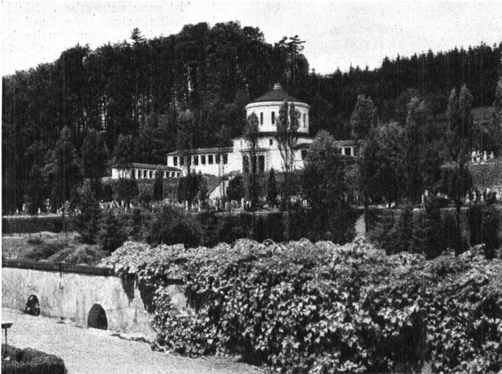
Abb. 3. Krematorium in Luzern. Gesamtansicht von nahe aus dem Friedental. — Fig. 3. Le crématoire de Lucerne : vue générale prise du Friedental.
