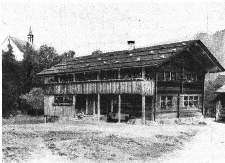
Fig. 11. Etat actuel de la maison de Flüe, après la restauration. — Abb. 11. Südwesthälfte des Geburtshauses, nach der Wiederherstellung.
