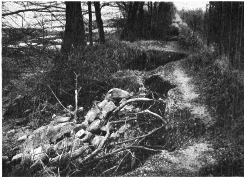
Abb. 18. Uferweg bei der Moosburg am Bodensee, durch das Hochwasser des letzten Sommers zerstört. Die Wiederherstellung stösst auf Schwierigkeiten. — Fig. 18. Chemin de grève de Moosburg, lac de Constance, qui a été détruit par les hautes eaux de l'été dernier. Le rétablissement de ce chemin rencontre des difficultés.
