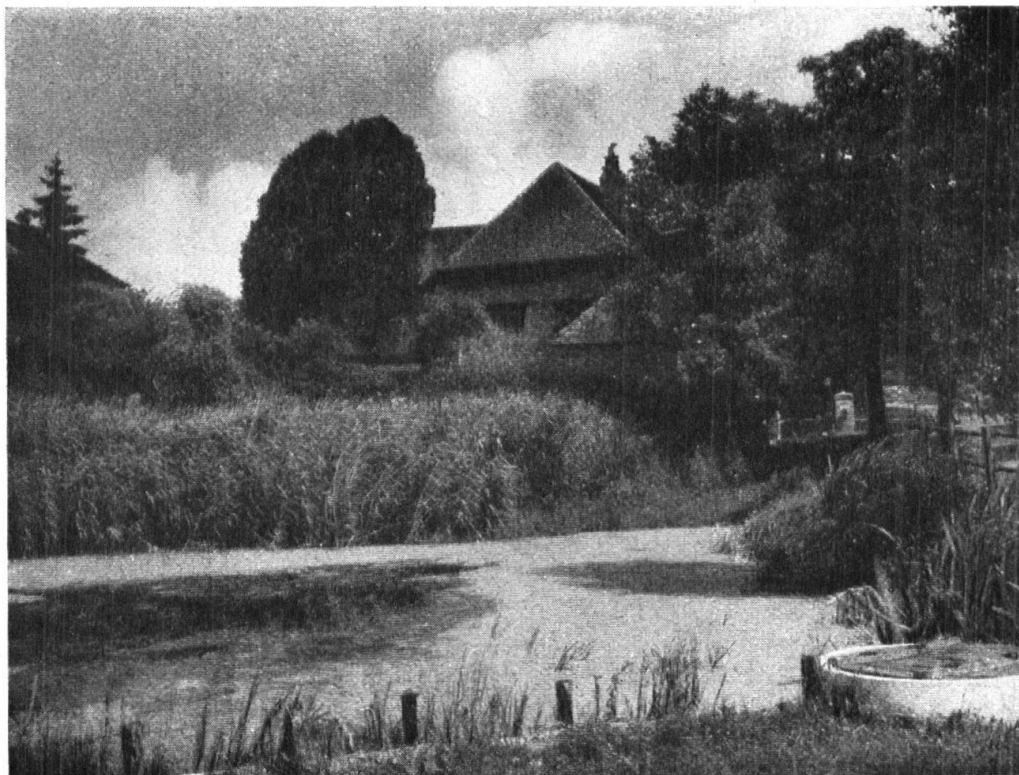
Abb. 2. Beispiel. Guter Feuerweiher in Herzwil, Kanton Bern. Das nächstgelegene Ufer ist mit Brettern und Pfählen befestigt, die im Wasser sehr lange haltbar sind. Durch das eingebaute Zementrohr rechts mit siebartigem Einlauf wird eine saubere Entnahmestelle für das Wasser geschaffen. — Fig. 2. Bon exemple. Joli étang à Herzwil dans le canton de Berne.
