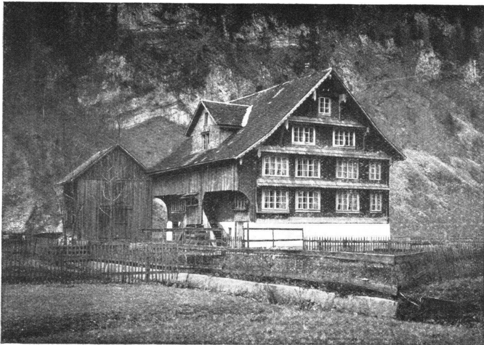
Abb. 5. Bauernhaus in Iberg (Schwyz). Wieder kein Walmdach, dafür Klebdächer. Die Gegend hat kein Getreide, nur Wiesen und Weiden, daher wenig Dachraum. — Fig. 5. Maison paysanne à Iberg (Schwyz). De nouveau un toit à deux pans seulement, mais des auvents protègent les fenêtres. La contrée ne connaît pas la culture du blé, on n'y rencontre que des prairies et des pâturages; aussi ne reste-t-il guère de place perdue sous les combles.
