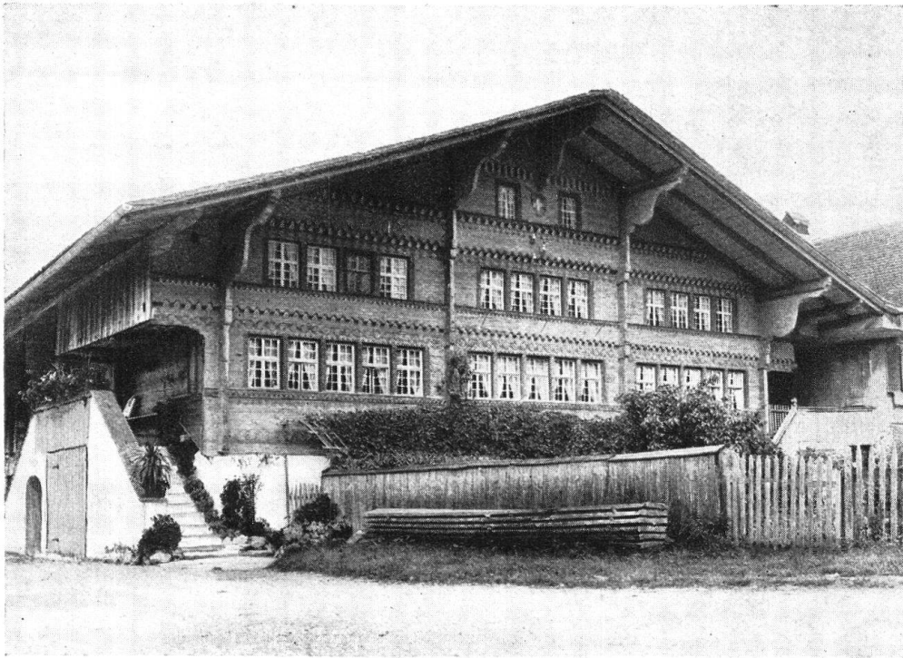
Abb. 2. Haus in Wimmis (Berner Oberland), Giebel ohne Walmdach, flaches Satteldach, Holzschnitzerei in der breiten Front. Die Gegend hat keinen Getreidebau, das Heu wird in Scheunen versorgt, deshalb ist wenig Raum unter dem Dach nötig. — Fig. 2. Maison à Wimmis (Oberland bernois). Toit aplati à deux pans. Large façade sous le pignon, décorée de sculptures en bois. Cette contrée ne connaît pas la culture du blé. On y serre le foin dans des bâtiments à part, les fenils; aussi n'a-t-on pas besoin de beaucoup de place sous le toit.
