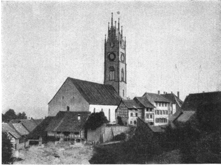
Abb. 11. Kirche von Andelfingen, welche die Häuser der Ortschaft schirmend überragt. Fig. 11. L'église d'Andelfingen qui domine, comme pour les protéger, les maisons du village.
