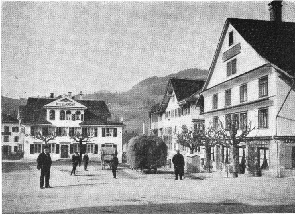
Abb. 7. Der Dorfplatz in Wald. Ruhiges, doch nicht eintöniges Dorfbild, mit charakteristischen Fassaden und Giebeln. Fig. 7. La place du village, à Wald. Place à l'aspect paisible, mais non monotone. Façades et pignons caractéristiques.
