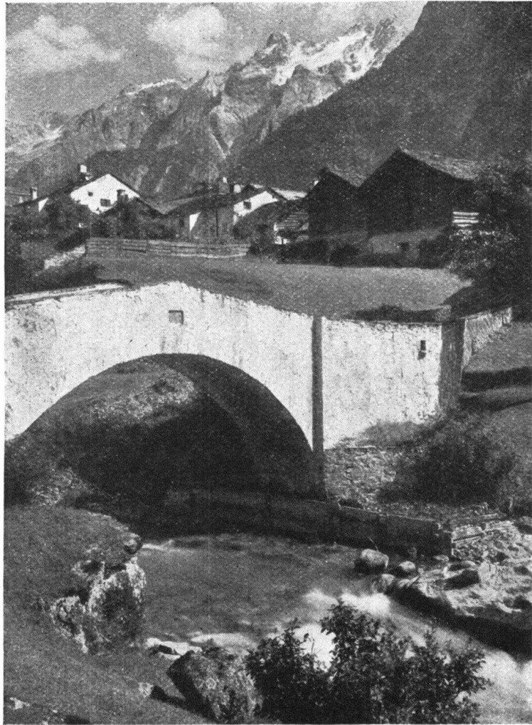
Abb. 3. Borgonovo im Bergell. Alte Steinbrücke mit ansteigender Fahrbahn in guter Vereinigung mit urwüchsigen Häusern und wildem Gebirgswasser. Fig. 3. Borgonovo dans le val Bregaglia. Vieux pont de pierre à dos d'âne, en harmonie avec les anciennes maisons de ce village original et les formes sauvages des montagnes.
