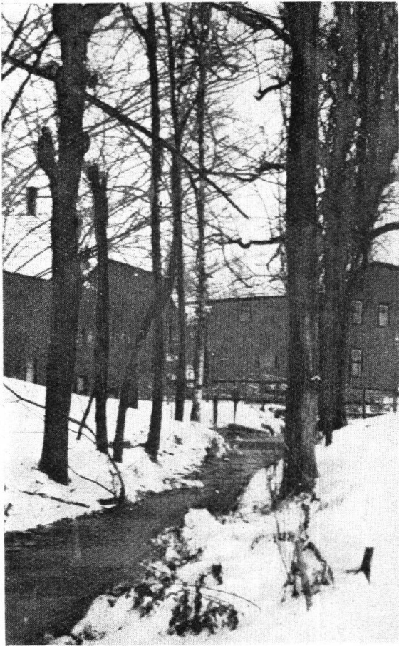
Abb. 8. Dorfbach in Oberdiessbach (Bern). Soll korrigiert werden. — Fig. 8. Le ruisseau qui traverse le village d'Oberdiessbach, canton de Berne, et qui doit être corrigé.
