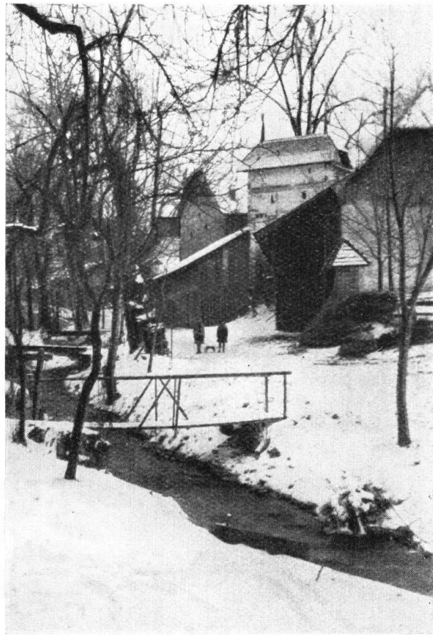
Abb. 9. Diessbach (beim Schloss Oberdiessbach). Winterbild. — Fig. 9. Le village de Diesbach, voisin du château d'Oberdiessbach. Vue prise en hiver.
