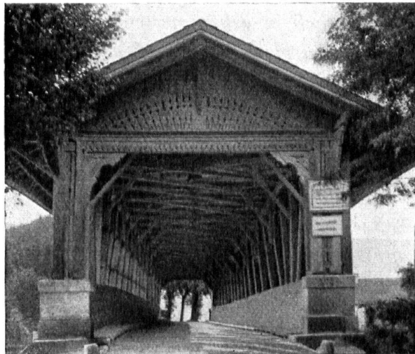
Brücke über den Zihlkanal. Pont de Saint-Jean, traversant le canal de la Thielle.
