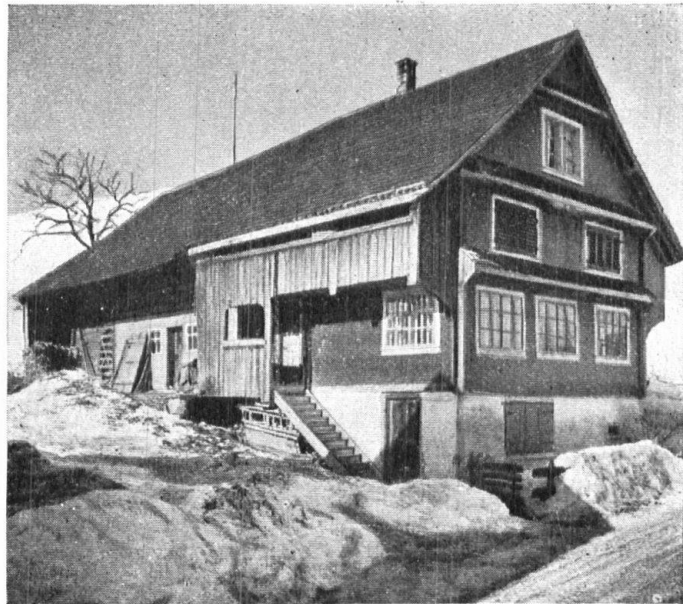
Gadenhaus mit fortlaufendem First.
