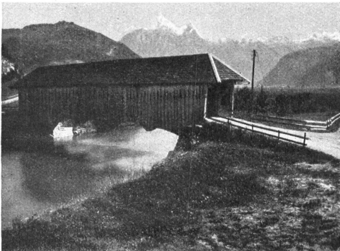
Holzbrücke in der Steinau.
