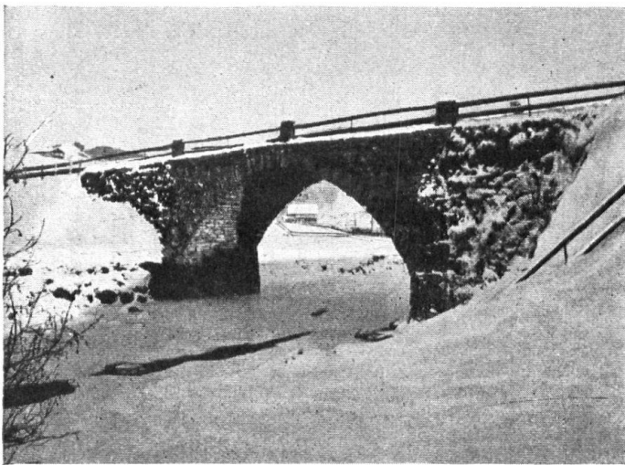
Die alte Bogenbrücke in der Jässenen.
