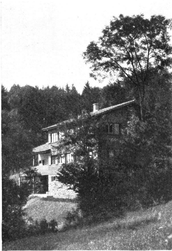
Holzhaus von Architekt J. Beeler in Wehrenbach bei Zürich. — Maison de l'architecte zurichois J. Beeler, très bien placée dans le paysage.
