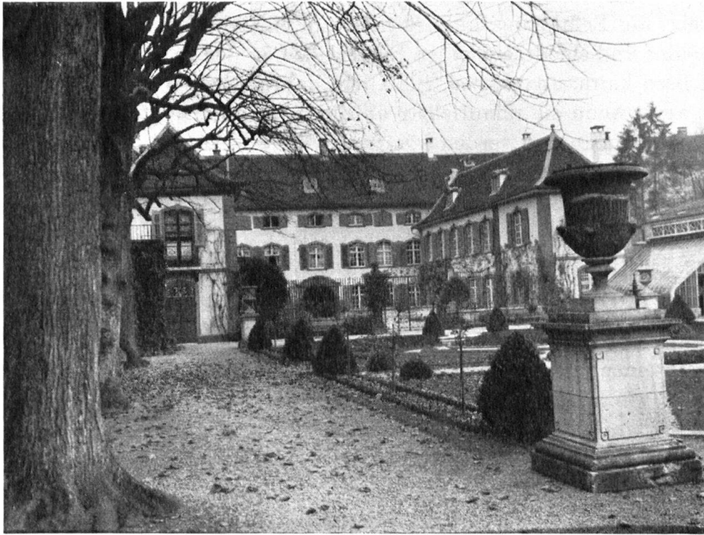
Der Wirtenbergerhof mit seinem reizvollen Park musste der neuen Kunstsammlung weichen. — Pour construire un nouveau Musée on vient de démolir un charmant hôtel rococo avec son parc qui était une merveille.
