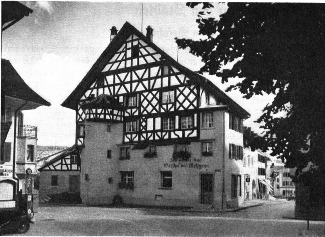
Die Freilegung des Fachwerks am alten Gasthof zum goldenen Kopf in Bülach.
