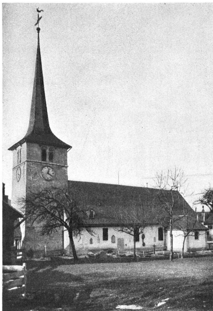
Ossuaire et Eglise de Grandvillard au canton de Fribourg, démolis en 1936 malgré l'intervention du Heimatschutz et des organes de l'Etat.
