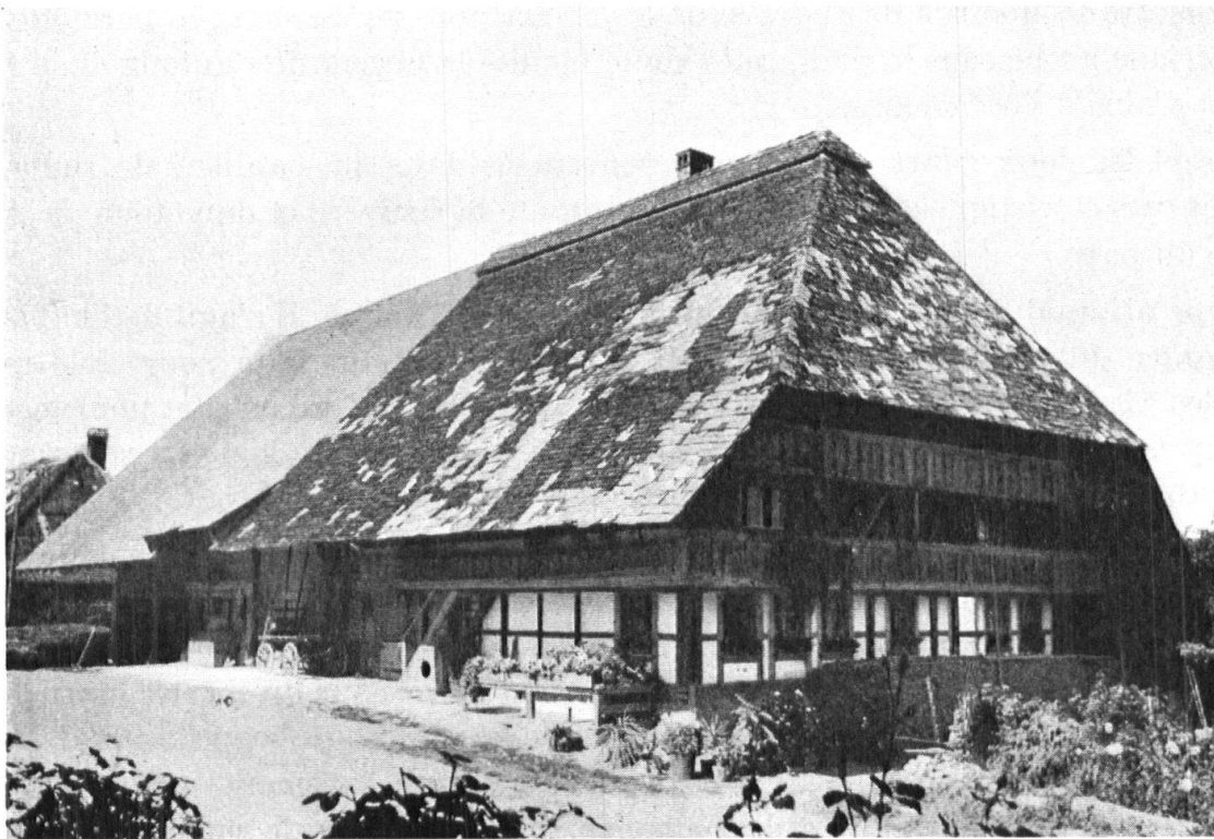
Fig. 6. Ulmiz : 1728. Ferme du district du Lac. Façade en règle-mur. Vaste toit à quatre pans. Double galerie, dont une en ceinture. — Riegelhaus in Ulmiz, Seebezirk. Schindeldach mit grossem Walm, 2 Galerien, die untere rings um das Haus.
