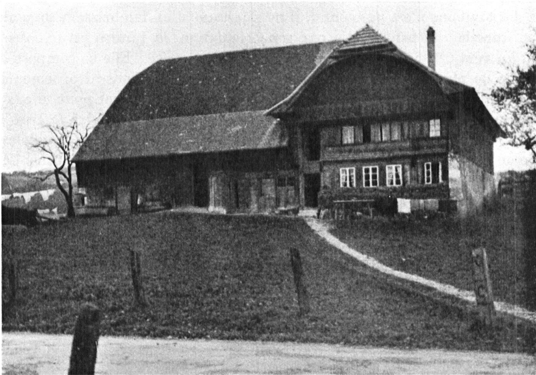
Fig. 2. Echarlens. Ferme gruérienne à « bogoz » avec galerie soustendant l'arche de pignon. Disposition habituelle : habitation, étable, aire, étable. — Freiburger Dreisässenhaus in Schärlligen, mit Ründe unter dem Krüppelwalmdach.
