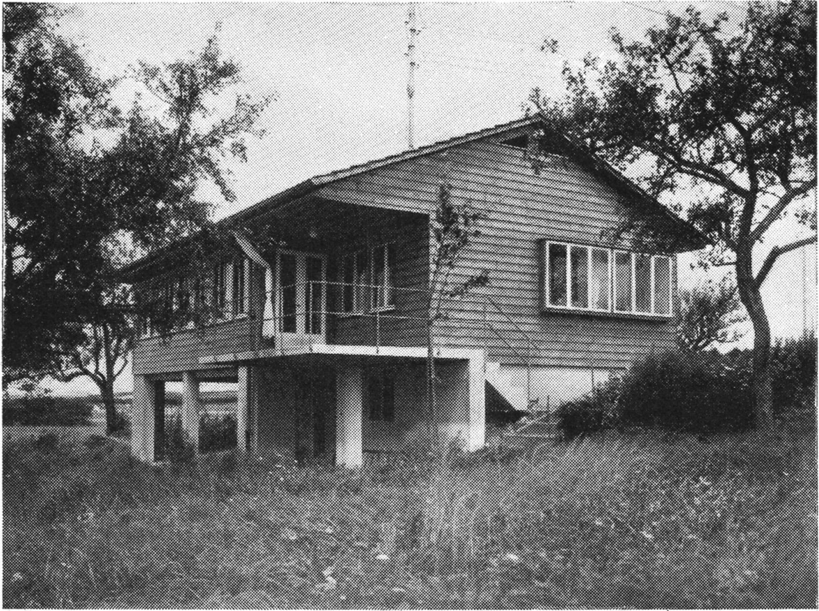
Haus Wettstein in Nänikon (Zch.), Arch. Gehry.
