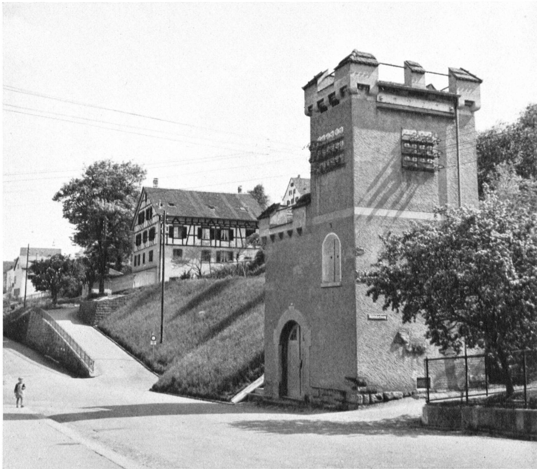
Endlich „Heimatschutz“!! Transformatorenhäuschen in Gestalt einer Ritterburg en miniature! Et enfin, ô merveille des merveilles, un transformateur « moyen-âge »! Avis au Heimatschutz!
