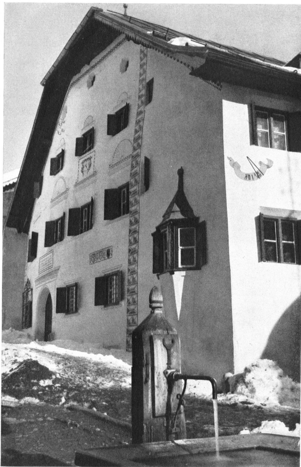
Behäbiges Herrschaftshaus nach der Renovation. Une belle restauration: maison seigneuriale, fièrement armoriée et dotée d'inscriptions.
