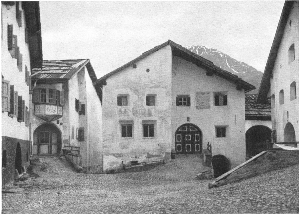
Dorfplatz vor der Wiederherstellung. Guarda, la place principale avant la restauration.
