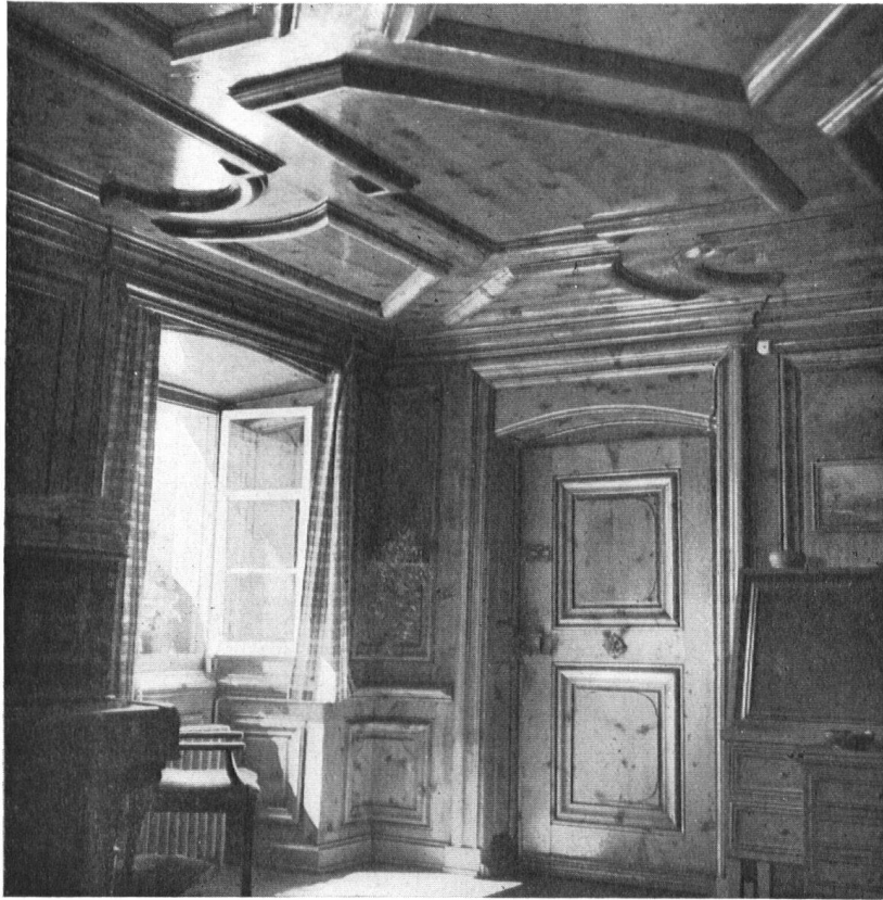
Splügen. Reiche Täferstube aus Arvenholz, um 1720, im Schulhaus (heute Amtswohnung des Pfarrers).
