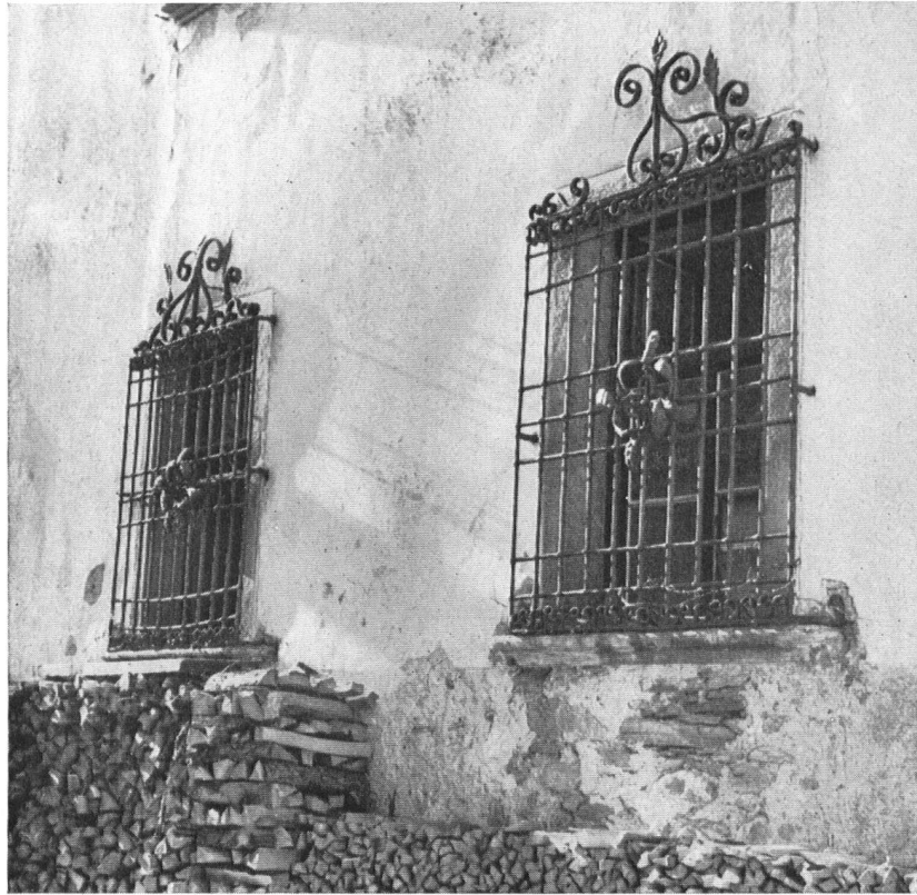
Splügen. Schmiedeiserne Fenstergitter am oberen Schorschenshaus. Les grilles de la maison Schorsch-Albertini (voir page 110) à Splügen.
