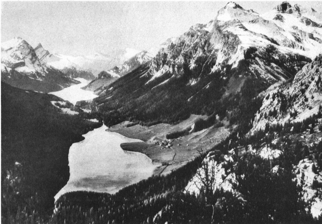
Das Rheinwald mit den beiden Seen bei vollem Aufstau. Unten der kleine See von Sufers, oben (perspektivisch verkürzt) der 9 km lange künstliche See von Splügen.
