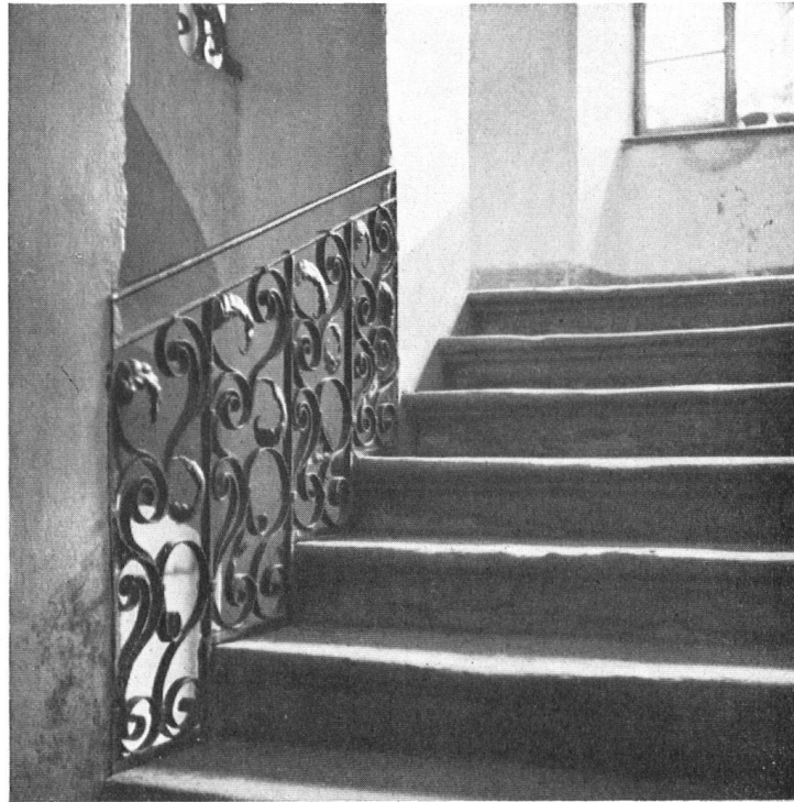
Splügen. Treppe im Schulhaus mit handgeschmiedetem Geländer.
