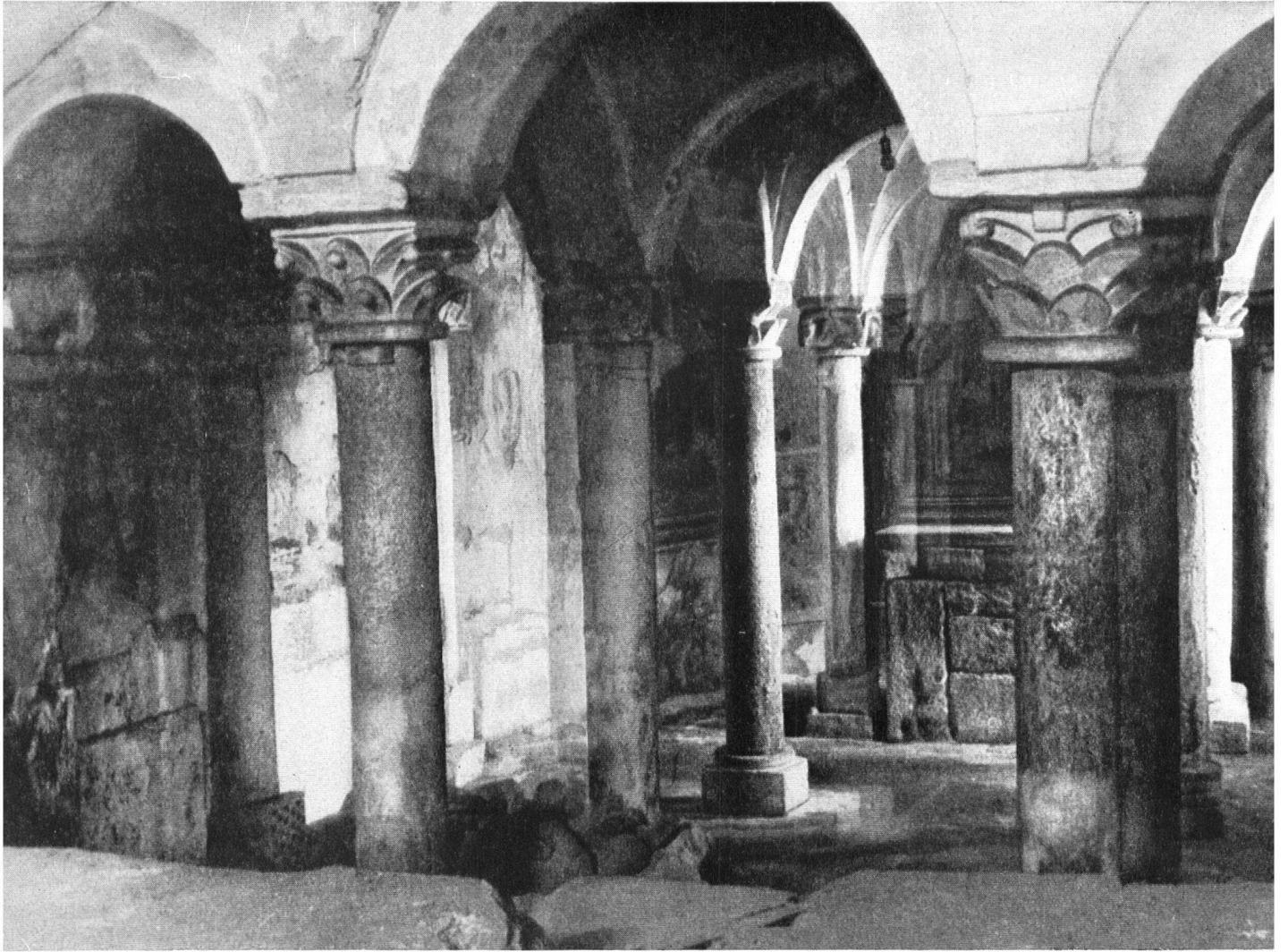
Die Unterkirche, ein besonders ernster, gruftartiger Andachtsraum für die Verehrung hier bestatteter Märtyrer oder Stifter. Säulen und Kapitelle aus Granit. L'on priait dans la crypte sur les reliques des martyrs et sur les tombeaux des fondateurs.
