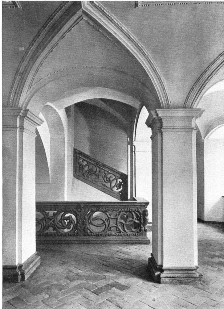
Das repräsentative Treppenhaus im 1. Stock. Das Geländer aus gehauenen Sandstein. La rampe d'escalier: balustrade en molasse ouvragée.
