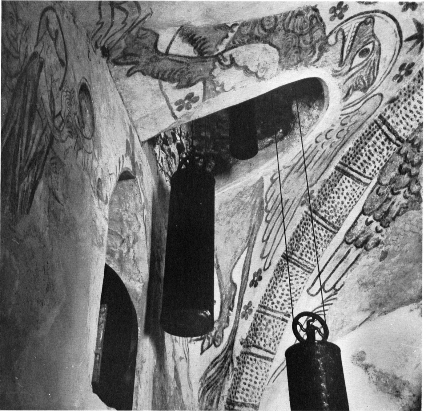
Kirche Zell. Das in die Fresken geschlagene Loch mit den Gewichten der Kirchenuhr. On détruit la décoration murale pour faire passer les contre-poids d'horloge. Chiesa di Zell. Gli affreschi rovinati per far posto ai pendoli dell'orologio.
