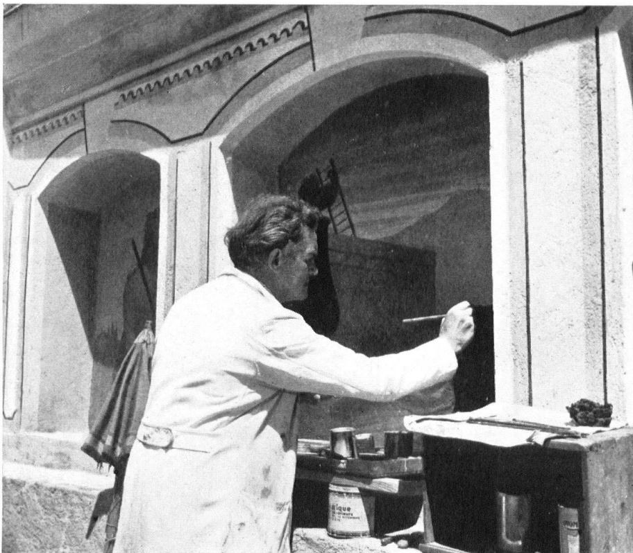
Die von Zerfall und Zerstörung bedrohten Bilder werden dank eines Beitrages des Heimatschutzes aus der Talerkasse und der Eidgenossenschaft durch Maler Ludwig Bär aus Klosters mit feiner Einfühlungsgabe wieder instandgestellt.
