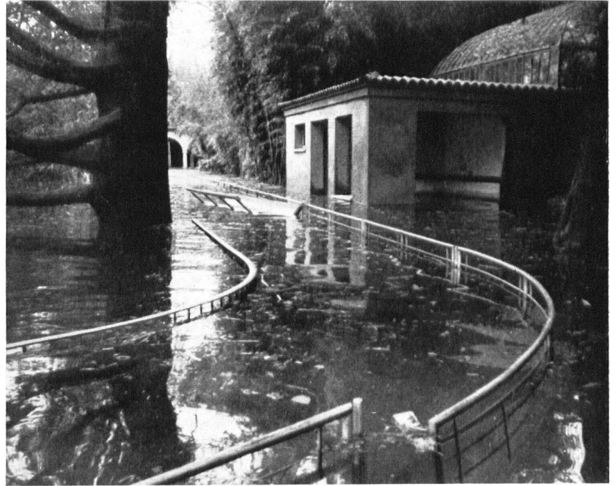
Eingang zur Insel. Neben der Zeder eine aus dem Wartesaal davongeschwommene Sitzbank.
