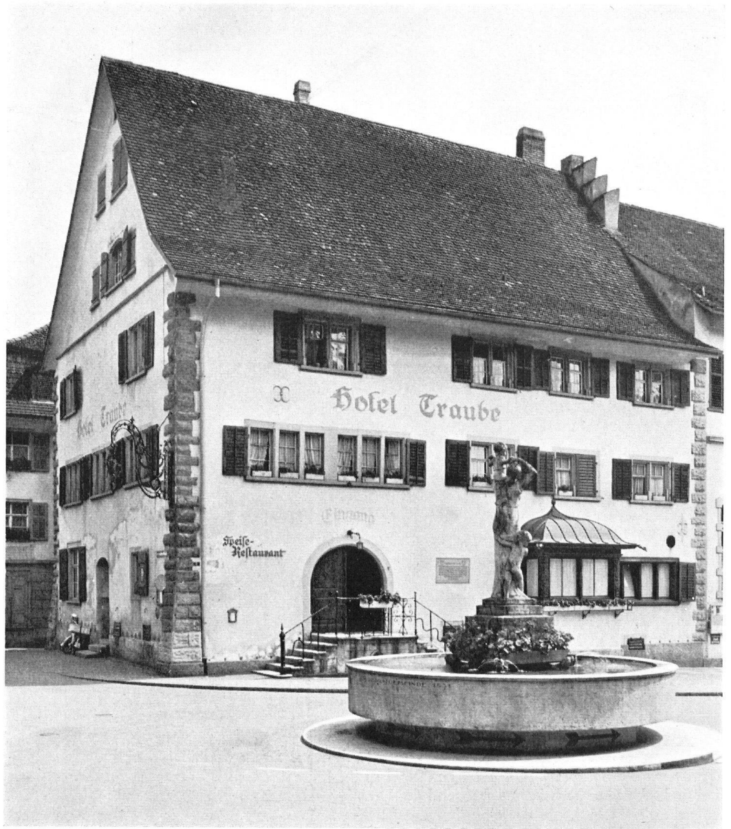
Das abbruchgefährdete Gasthaus «Zum Trauben» in Weinfelden.
