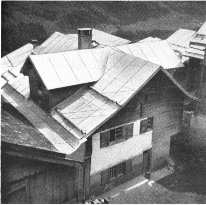
Bauernhaus in Cumbel, Lumnezia. Durch den erweiterten Anbau der zwei Seitengiebel (Dachkammern) wurde der Charakter dieses Bauernhauses zerstört. Dazu kommen noch die schreckliche Verblechung und die 'schönen' Kamine.
