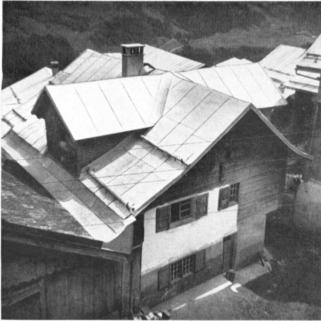
Maison paysanne à Cumbel, Lumnezia. La construction de deux chambres de chaque côté du toit a tout à fait détruit le caractère de la maison. A quoi s'ajoutent la couverture en tôle et la cheminée!
